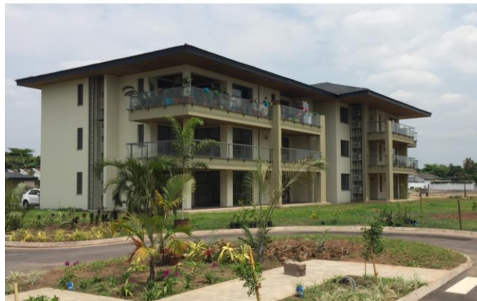
Un des quatre nouveaux immeubles du Clos des Musiciens
